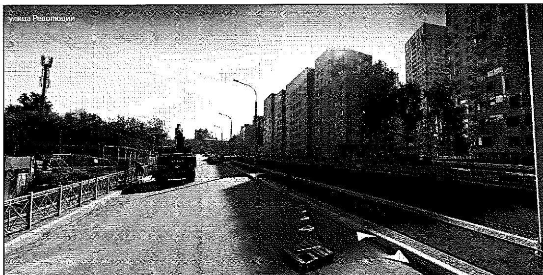
Рисунок 5.1.2.5 - Реконструкция ул. Революции, г. Пермь с целью организации движения автобусов по обособленному трамвайному полотну
