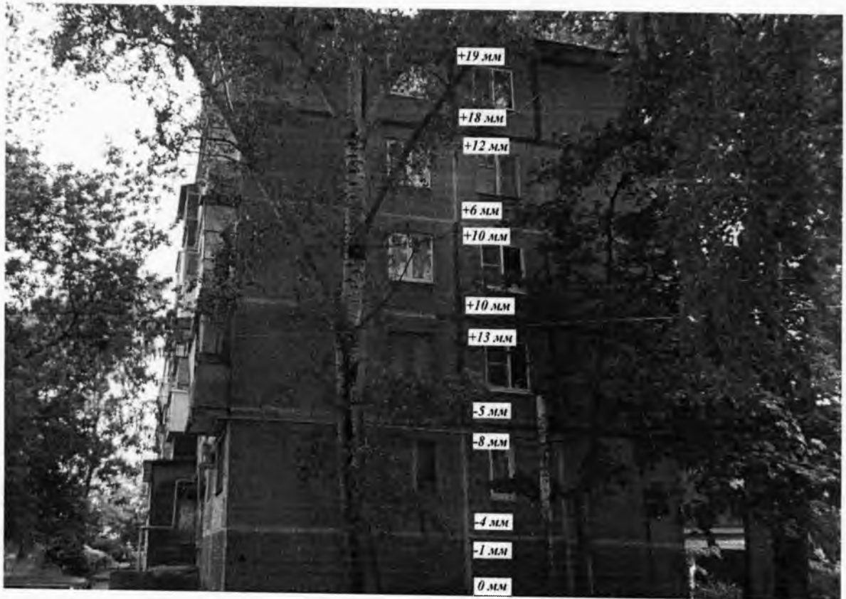
Рисунке №5. Измерения вертикального отклонения с торца здания.
