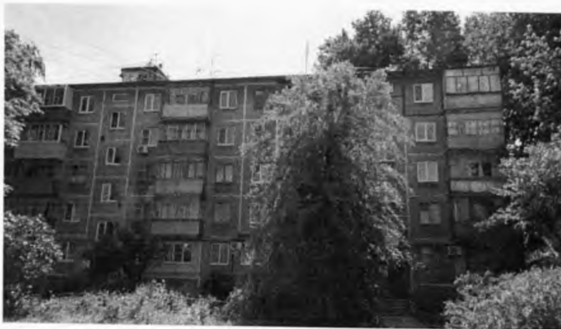
Рис. №3. Фасад 3-го подъезда.
